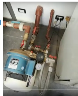
Figura 9. Tanque hidroneumático con provisión desde Tanque de Reserva.
